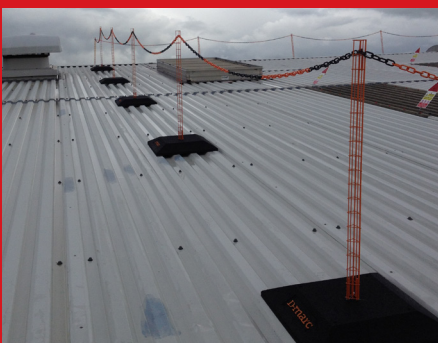
Mobile Dachabsperrungen
