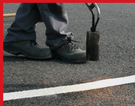
Termoplastické značení na asfalt a beton
